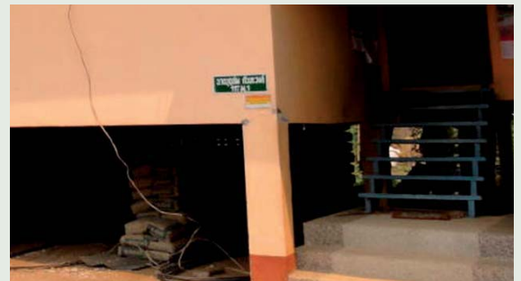
รูปที่ 8 อาคารคสล. 4 ชั้นของข้าราชการสุลกการอำเภอแม่สาย จังหวัดเชียงราย แสดงความเสียหายแบบเฉือนในเสาและเสาเล็ก เสาแตกร้าวจากแผ่นดินไหว (ตำบลเวียง อำเภอเชียงแสน จังหวัดเชียงราย)
