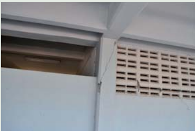
รูปที่ 7 แสดงการวิบัติแบบเฉือนของเสาสั้นในอาคารพักอาศัย คสล. 4 ชั้นของข้าราชการสุลกการอำเภอแม่สาย จังหวัดเชียงราย
