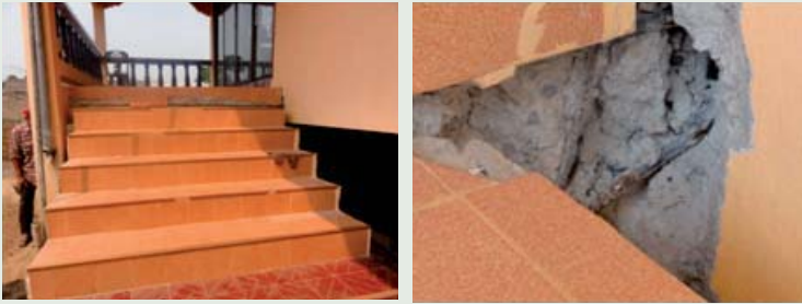
รูปที่ 14 ระยะยึดรั้ง (anchorage length) ของเหล็กเสริมคานฝังในเสาไม่เพียงพอ (อาคารเดียวกับรูปที่ 8)
