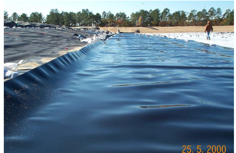
การวางระบบกันซึม
