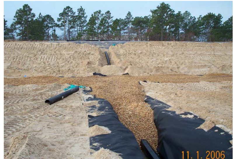
การวางท่อระบายน้ำชะขยะ
