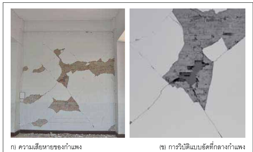
รูปที่ 11 ความเสียหายและการวิบัติของกำแพง
