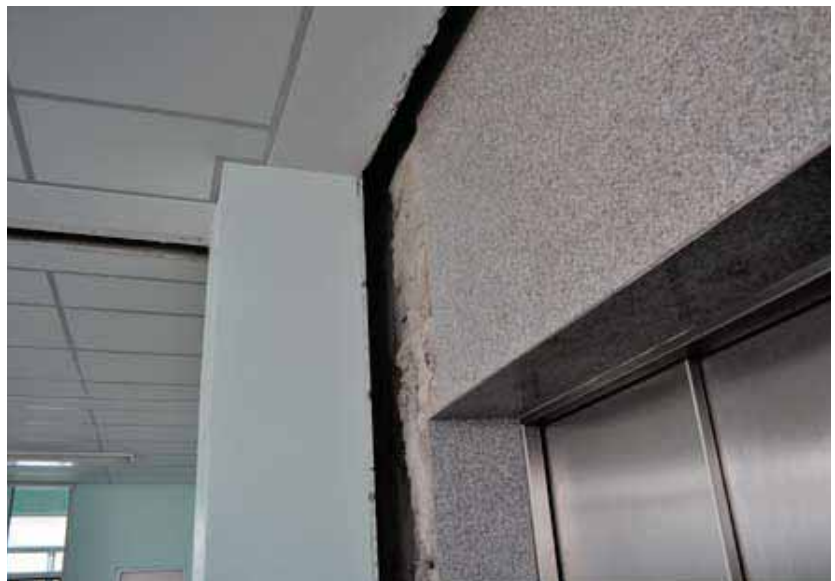
รูปที่ 19 อาคาร 68 ปิณสุรณ โรงพยาบาลเชียงรายประชานุเคราะห์ อ.เมือง จ.เชียงราย
