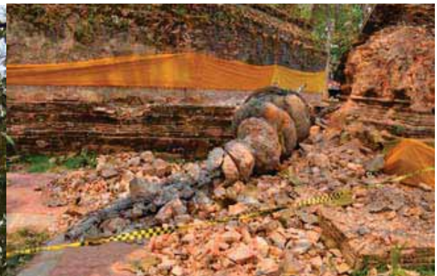
รูปที่ 8 ความเสียหายของพระธาตุเจดีย์หลวง
