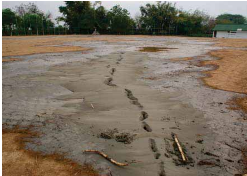
รูปที่ 21 การเกิดลิกวิแฟกชันที่สนามกีฬาตำบลแม่สาย ต.แม่สาย อ.แม่สาย จ.เชียงราย (ภาพโดย คุณนคร อภิไชย)
