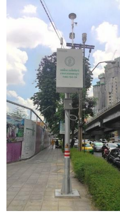
รูปที่ 5 สถานีตรวจวัดคุณภาพอากาศแบบตั้งบนเสาเหล็กของกรุงเทพมหานคร ที่บริเวณริมถนนปทุมวัน
