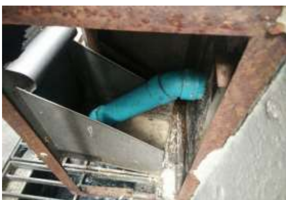
ภาพที่ 9 ท่อระบายน้ำ 1
