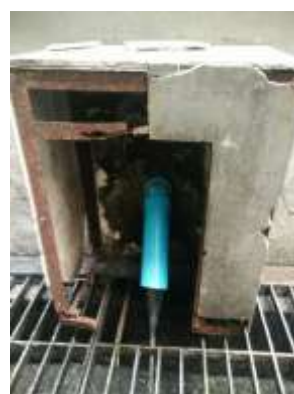
ภาพที่ 10 ท่อระบายน้ำ 2
